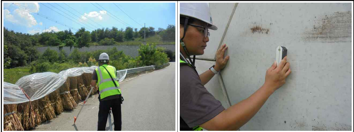
【사진 13.4.2】 측량작업 전경
