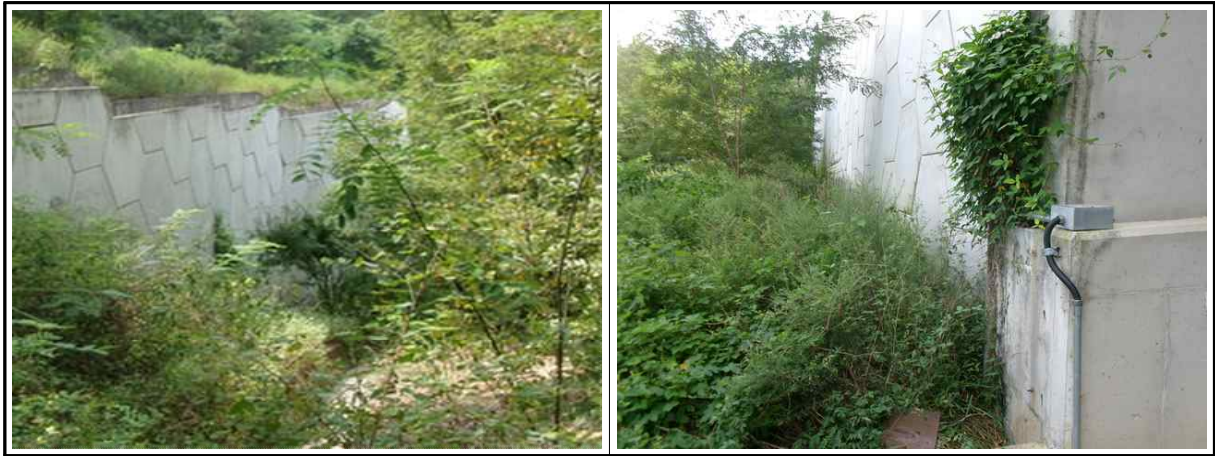
【사진 13.3.1】 지반, 기초부 전경
